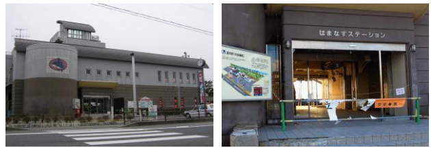
図-5 大谷海岸駅の津波被害. 左: 被災前, 右: 被災後
