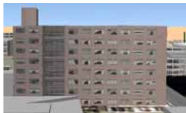
図 11 壁柱窓に損傷が入った様子
