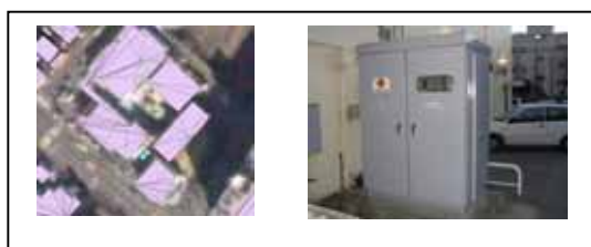
図10 真砂4・5丁目における建築物ではない構造物
