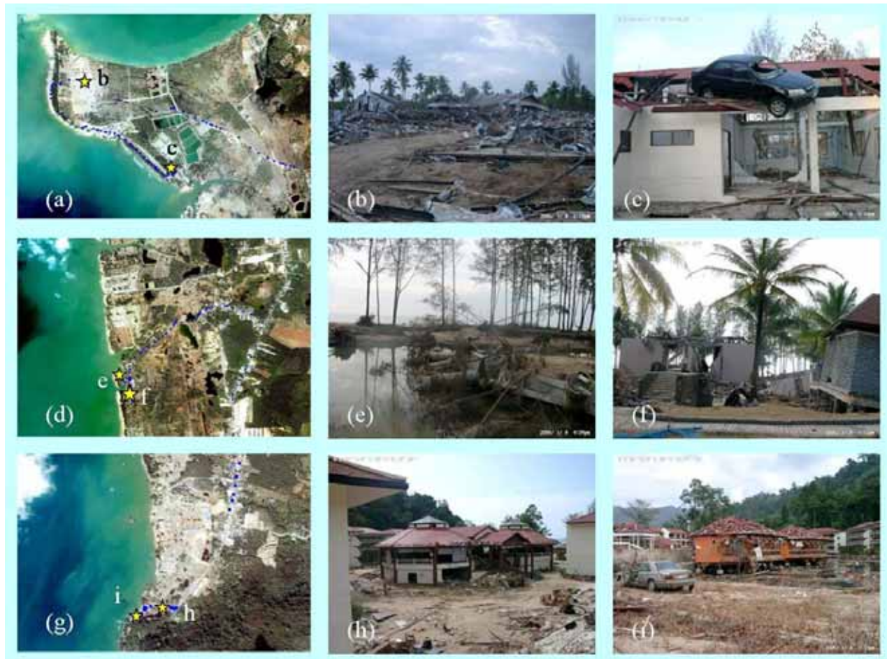
図4 パンガー県カオラック周辺の IKONOS 衛星画像(2004/12/29)と被災状況。青い点は位置つき写真の撮影位置、☆は図に示す写真撮影位置である。(a) Phakarang 岬、(b) 壊滅した Bamboo Orchid Resort、(c) 屋根に打ち上げられた車、(d) Khao Lak 中部の気象局周辺、(e) 津波で流された橋、(f) 破壊されたコテージ、(g) Khao Lak 南部の Nang Thong beach 周辺、(h) & (i) 津波で壊滅的な被害を受けた Similana Resort。
