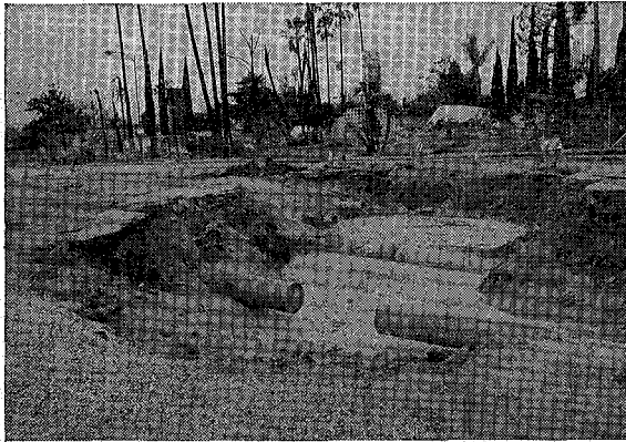
写真-3 パルボア通りの埋設管引張り破断現場
