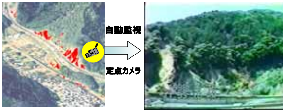
図 7 定点カメラが捕らえた斜面崩壊の瞬間 (NTT インフラネット提供)
