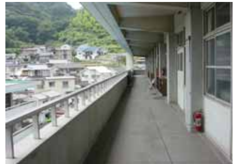
写真1 呉市内の小中学校に多い開放廊下
