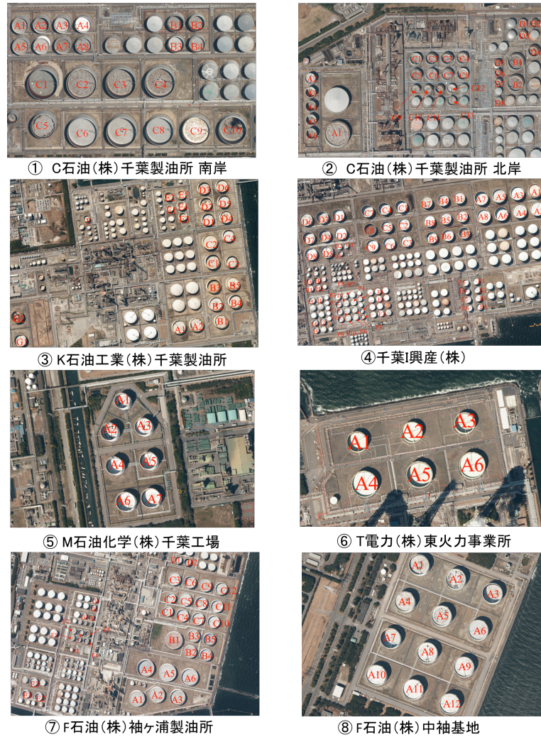
図3 検討対象である各製油所の対象タンク（番号のついたタンク）の空撮画像
