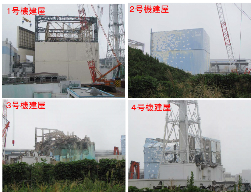
図13 2011年9月15日の各原子炉建屋の状況（東京電力資料 35) ）
