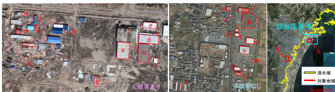
図4 倒れ込み範囲を用いた被害把握手法の検討対象地と対象建物（被害あり a-m、被害なし n-z）
