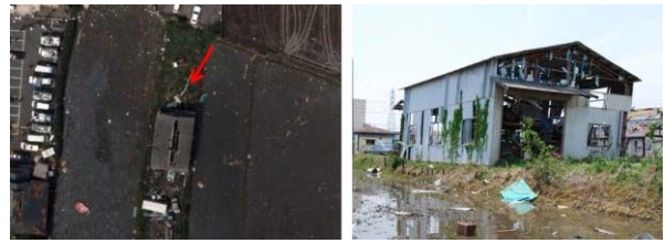
図 10 航空写真判読で被害を過小評価した非木造建物
