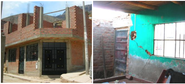
写真1 (左) RC補強部材を持つ建物 (右) RC補強部材のない建物(屋内)
