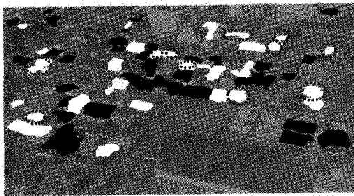
図-6 図-5の目視判読 7) と地上調査 21), 22) の結果。黒：倒壊建物，白：全壊建物，点線：ブルーシートを表す。
