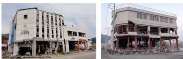
図 8 東日本大震災で多数見られた津波による堅ろう建物の下部・側面の被害の様子（筆者撮影）
