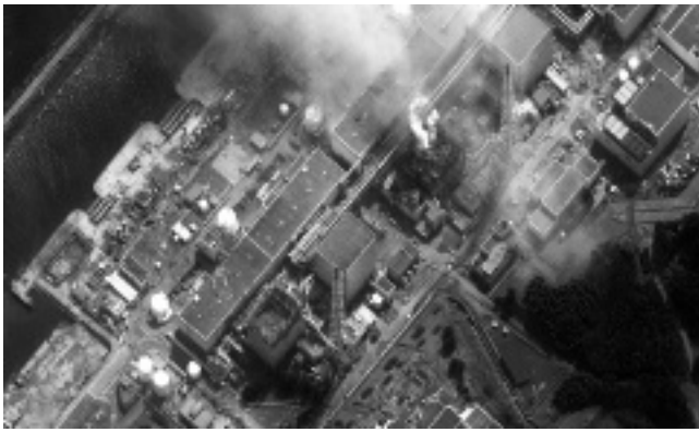
写真-2 福島第一原子力発電所の3号機建屋爆発直後の様子 (DigitalGlobeウェブサイト)
