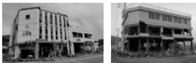
写真-3 東日本大震災で多数見られた津波による堅ろう建物の下部・側面の被害の様子（筆者撮影）
