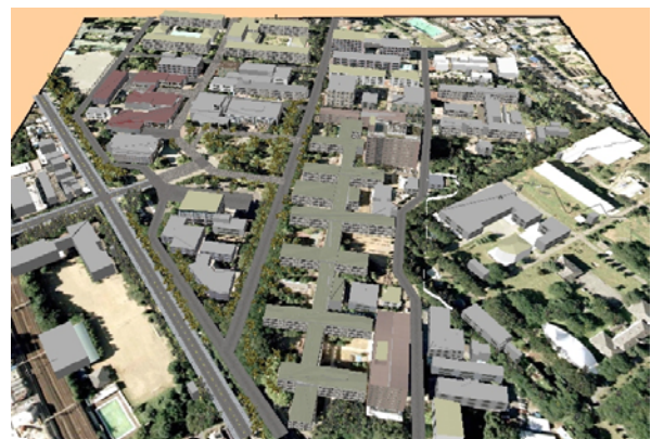
図-11 3次元都市モデル MAPCUBE に航空画像や建物側面写真を貼り合わせて構築した千葉大学西千葉キャンパス 32)
