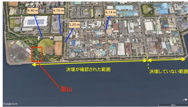
図-4.1.2.2 福浦地区の衛星写真. 浸水高さの計測結果は氾濫時の天文潮位からの高さに補正した. さらに護岸が決壊した領域と築山の位置を示した. (Google Earthに加筆)
