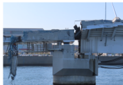
PC栈橋と箱桁橋の接合部分②
