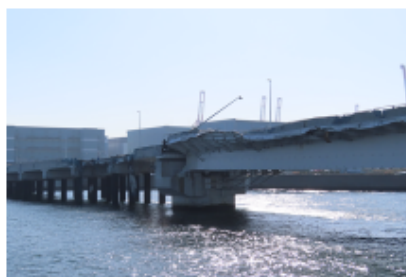
PC栈橋と箱桁橋の接合部分①
