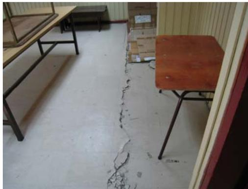
各部屋で床スラブの沈下やひび割れが見られた
