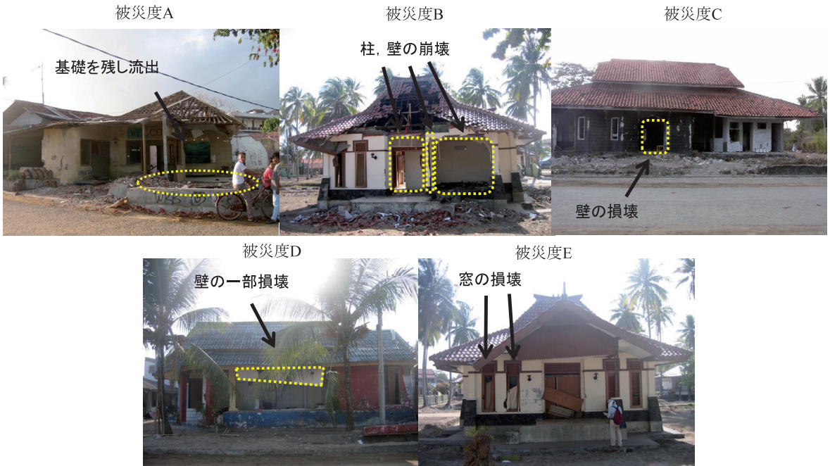
図-2 家屋の被害事例
