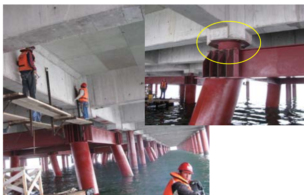
鉛プラグ入り積層ゴムによる免震要素設置棧橋 地震後点検状況
