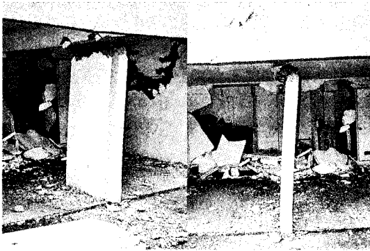
写真9 東構面北側壁柱の被害（大破建物）
