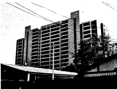
写真1 Sol Oriente 1 and 2 建物外観
