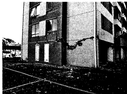
写真8 南妻壁(大破建物)
