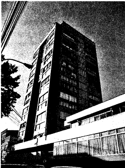
写真10 Lincoyan 440 建物外観（大破）
