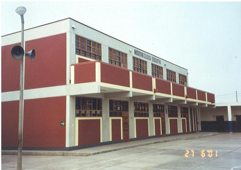
**Fig.3.** Centro educativo diseñado con la Norma Sismorresistente de NTE 0.30/ 1997 y 2003. Ningún edificio construido con dicha norma sufrió daños en los sismos de las regiones Arequipa de 2001 e Ica de 2007. La fachada posterior es idéntica a la mostrada en la fotografía.
