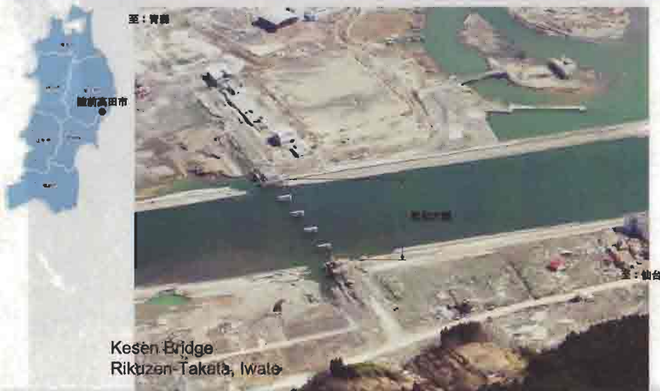
・津波により橋梁上部工が流出(岩手県陸前高田市気仙大橋)
