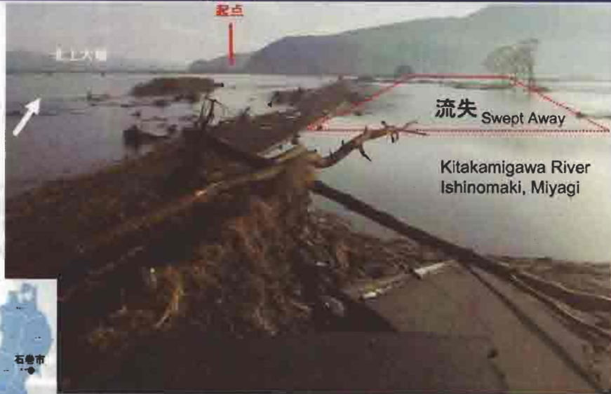
・津波による道路兼用堤防流出(北上川:宮城県石巻市釜谷地区)
