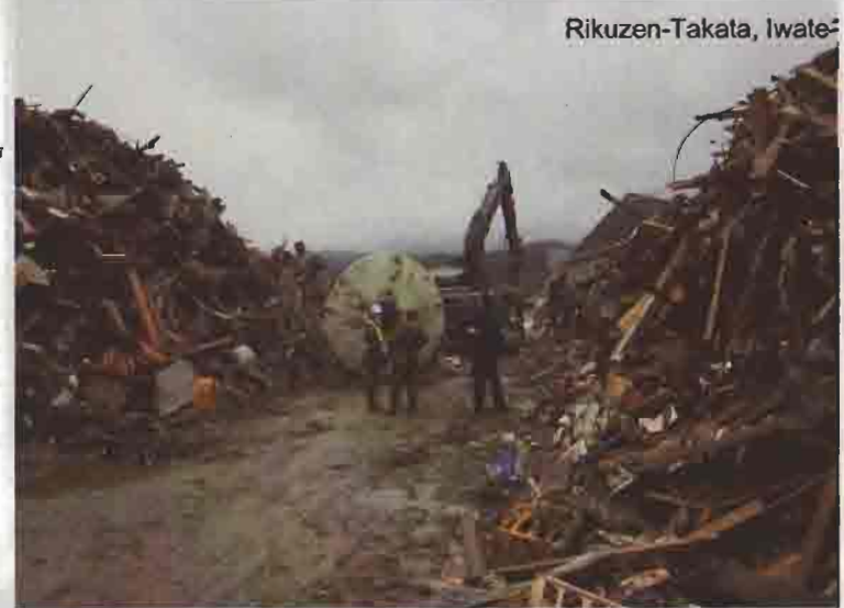
・津波により災害を受けた岩手県陸前高田市市内の道路啓開状況
