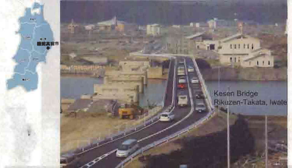
・仮橋を架橋し、交通路を確保(宮城県陸前高田市気仙大橋)
