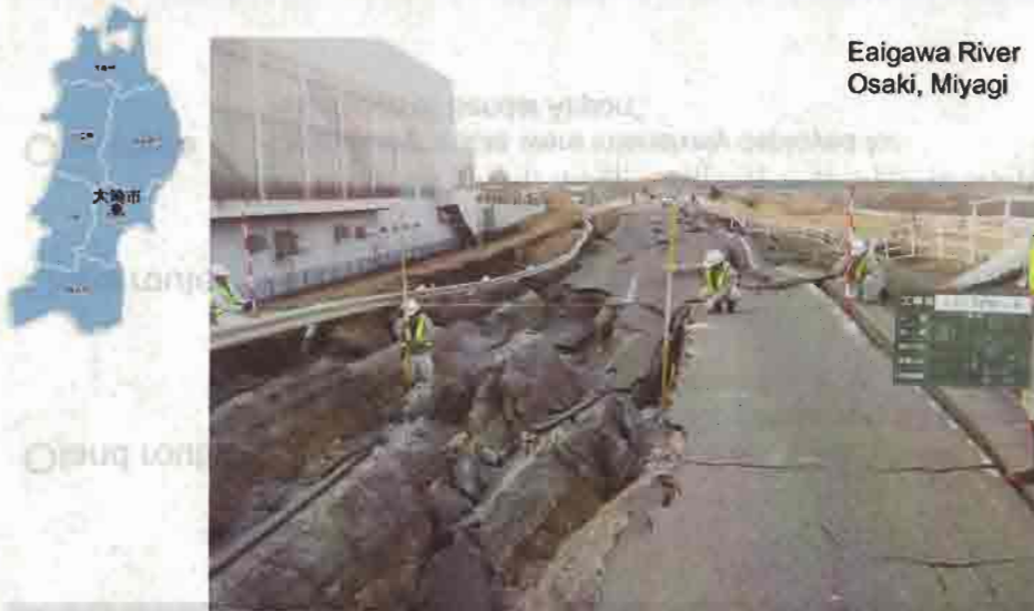
・江合川の緊急復旧状況(宮城県大崎市福沼地先)
