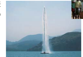
ニオス湖におけるCO 2 ガス抜きパイプの大噴水
