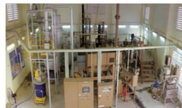
ホーチミン市工科大学内に設置されたバイオマスプラント。稲わらからの地域完結型バイオエタノール生産に必要な技術の検証を行う。
