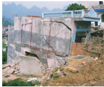
ベトナムの州都ソントラの地すべりによる住宅の被災
