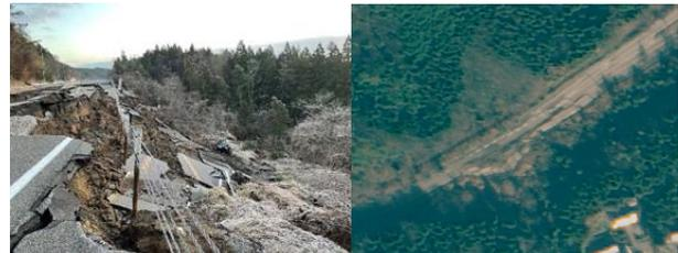
図-1 横田IC付近の現地被害写真(左) 衛星画像(右)
